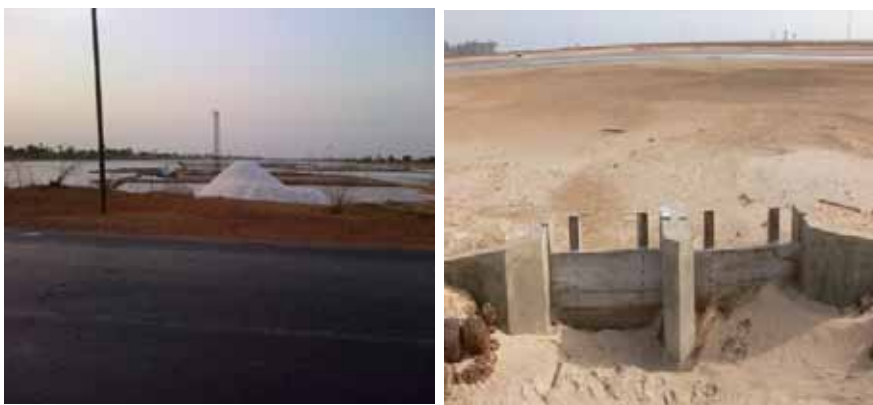
Espaces agricoles envahis par l'avancée saline Ouvrage anti-sel sommaire (département de Fatick)
